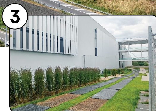
Entre les deux bâtiments blancs, tournez à droite
